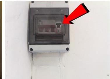
3. A continuación bajará los interruptores del tablero de oxígeno ubicado en la pared de la sala de gases medicinales.
