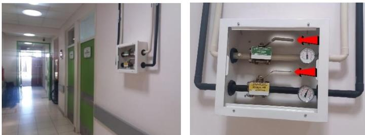
2. Si esto no es posible, entonces se realizará el corte desde el interior de la sala de gases medicinales, girando las perillas del tablero de aire comprimido hacia el lado izquierdo hasta llegar a OFF.
