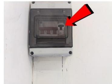
3. A continuación bajará los interruptores del tablero de oxígeno ubicado en la pared de la sala de gases medicinales.
