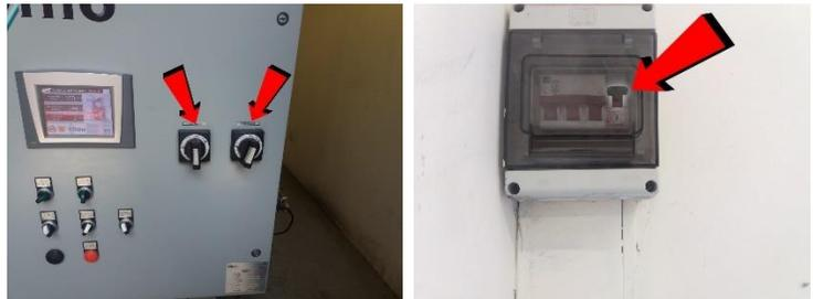
3. A continuación bajará los interruptores del tablero de oxígeno ubicado en la pared de la sala de gases medicinales.
