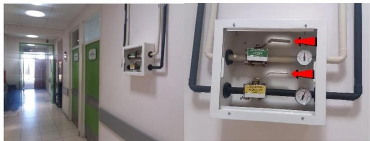
2. Si esto no es posible, entonces se realizará el corte desde el interior de la sala de gases medicinales, girando las perillas del tablero de aire comprimido hacia el lado izquierdo hasta llegar a OFF
